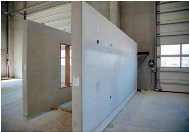
Abb. 11: Frisch ausgeschalte Wände - mit Ausnahme der Einfüllseite sind alle fünf Seiten und die Kanten und Flächen der Aussparungen absolut schalungsglatt.
